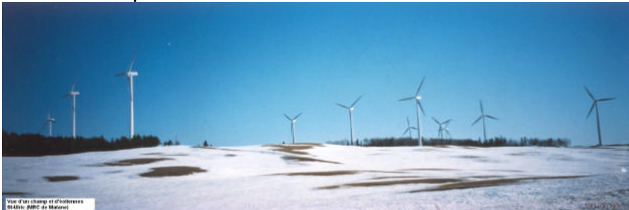
Crédit photographique : Julie Potvin, Baie-des-Sables
