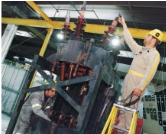
Réfection d'équipements en atelier.
