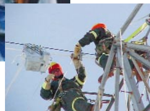
Remplacement d'un câble de garde à proximité d'une ligne sous tension selon la procédure poulies-berceaux.
