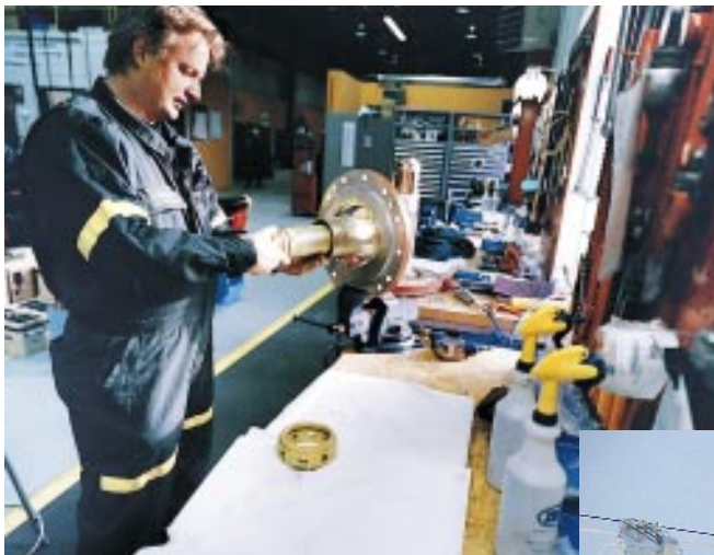
Remise à neuf des disjoncteurs.
