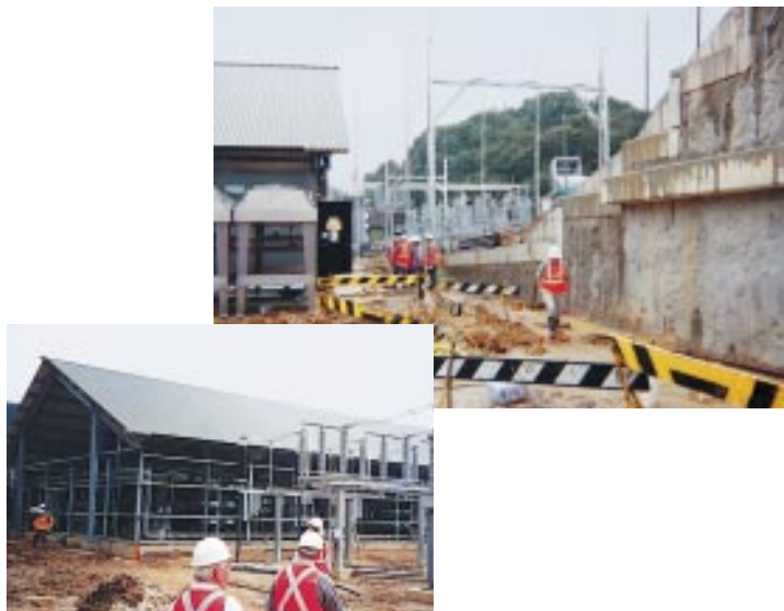
Construction d'un poste de transformation dans le cadre du projet Directlink, en Australie.
