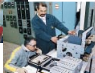
Vérification des disjoncteurs.
