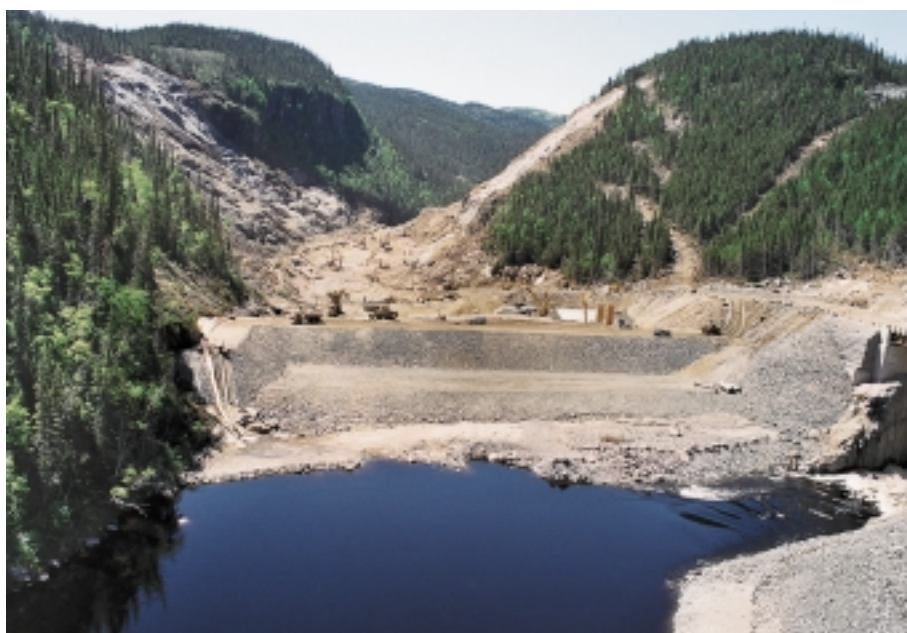
Chantier de la Sainte-Marguerite-3
