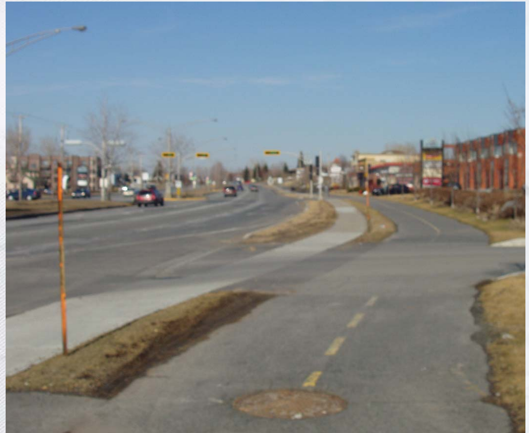
Corridor d'énergie souterrain
