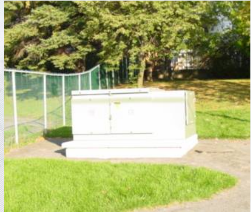
Appareil interrupteur souterrain VISTA
