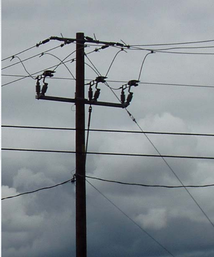
Sectionneur - interrupteur 600 A
