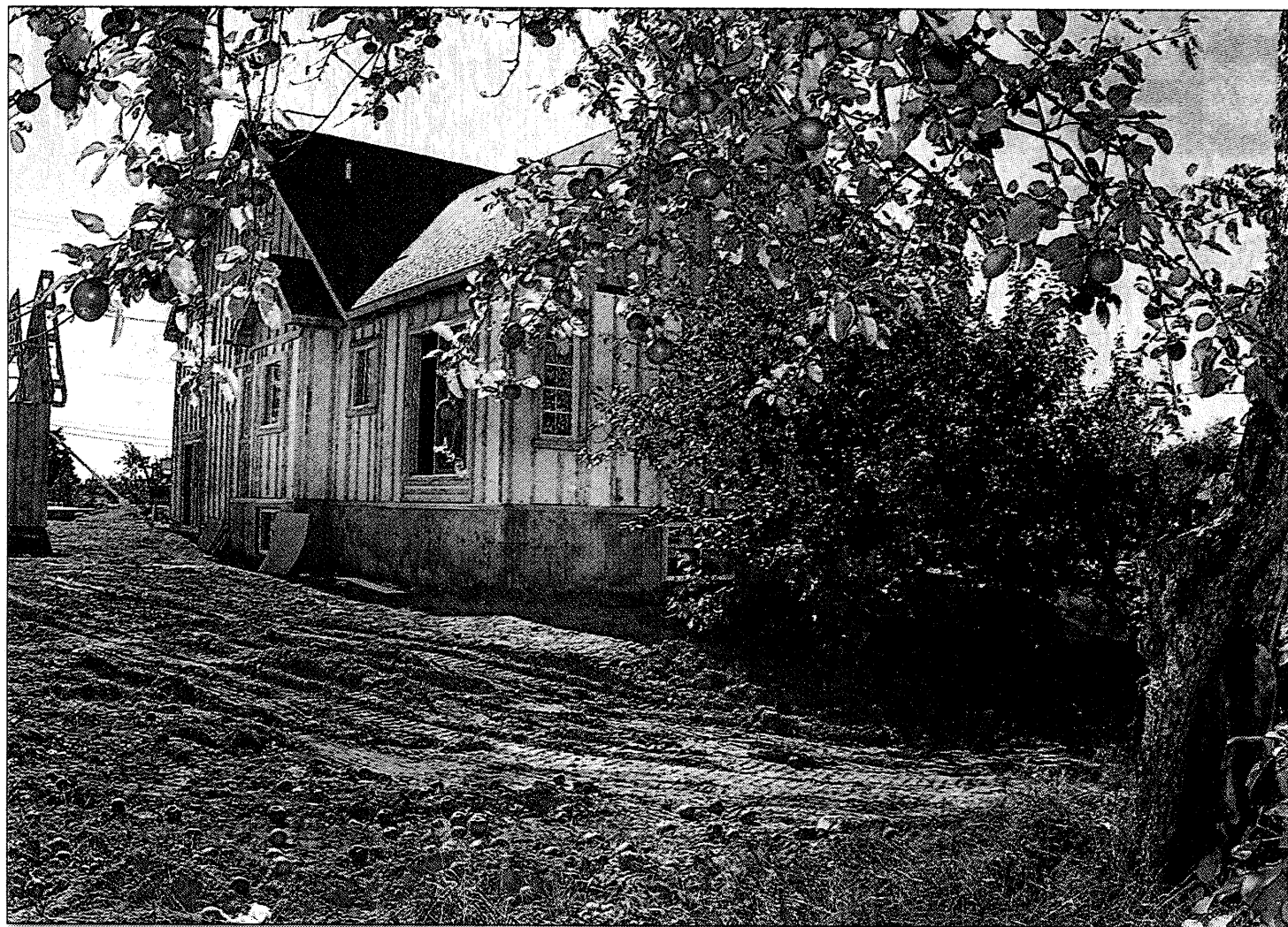
Une maison en construction du projet Éco Domaine, à Otterburn Park. Un vieux pommier apporte sa touche champêtre au site.
