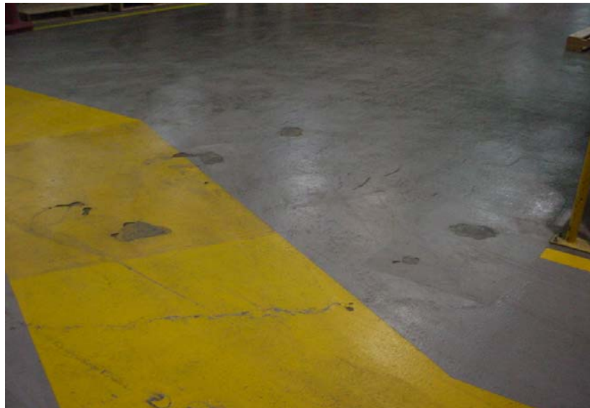
Photo no 4 État général des surfaces de plancher dans les entrepôts
