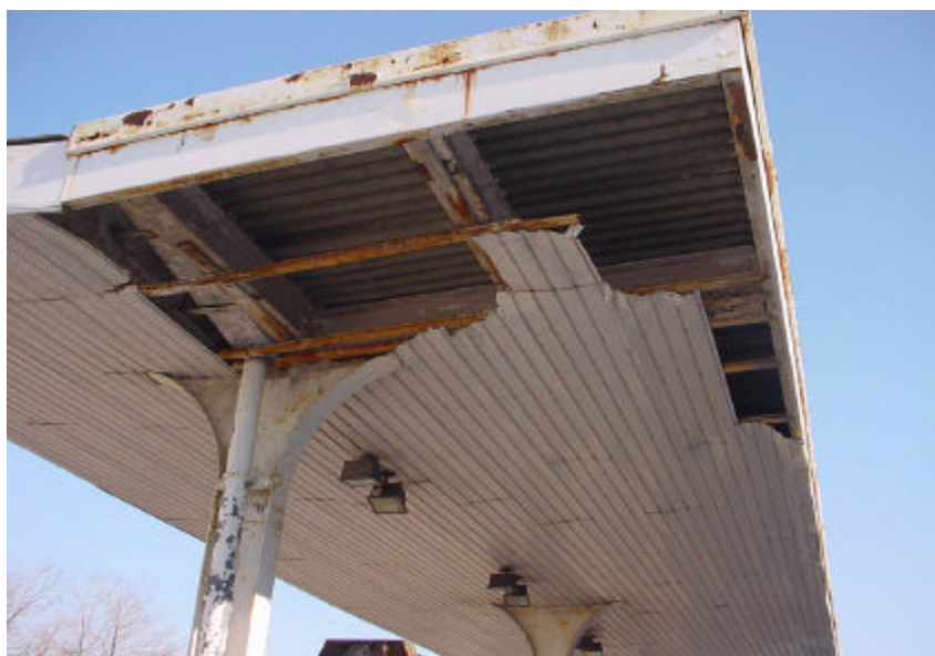
Photo no 2 État actuel de la structure et du soffite du poste d'essence
