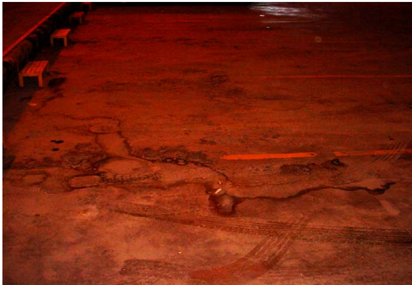
Photo no 7 État général des surfaces de plancher dans les garages
