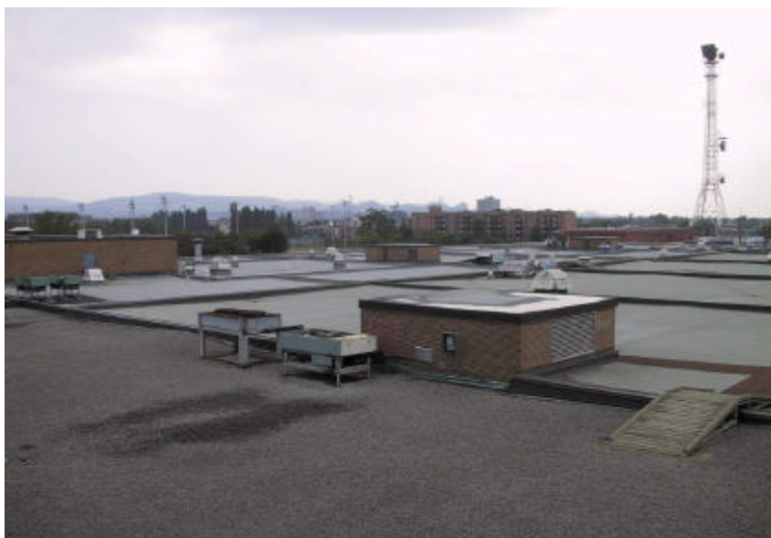
Photo no 24 Appentis en briques typiques à démolir
