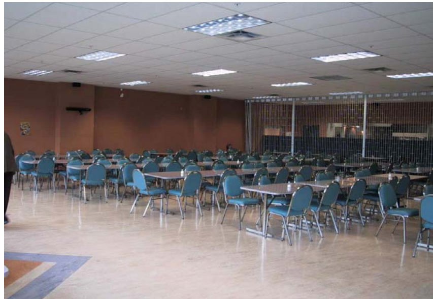
Photo no 2 État actuel du plafond dans le secteur des bureaux au 2e étage (cafétéria)
