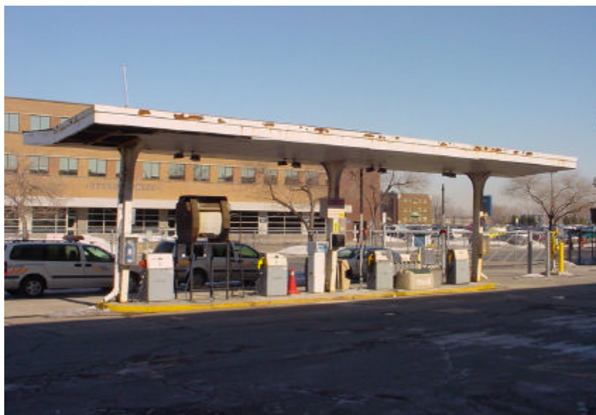
Photo no 1 Vue d'ensemble du poste d'essence existant
