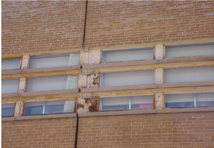
Photo no 13 État actuel de la fenestration aux endroits où les fenêtres sont d'origine (façade Jarry)
