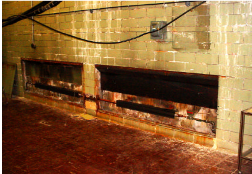
Photo no 9 Encastrement des appareils de chauffage
