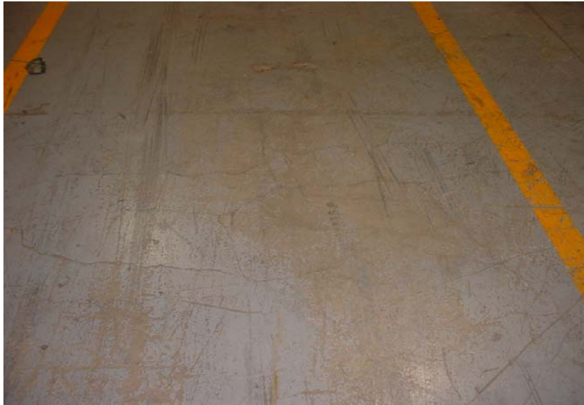
Photo no 3 État général des surfaces de plancher dans les entrepôts
