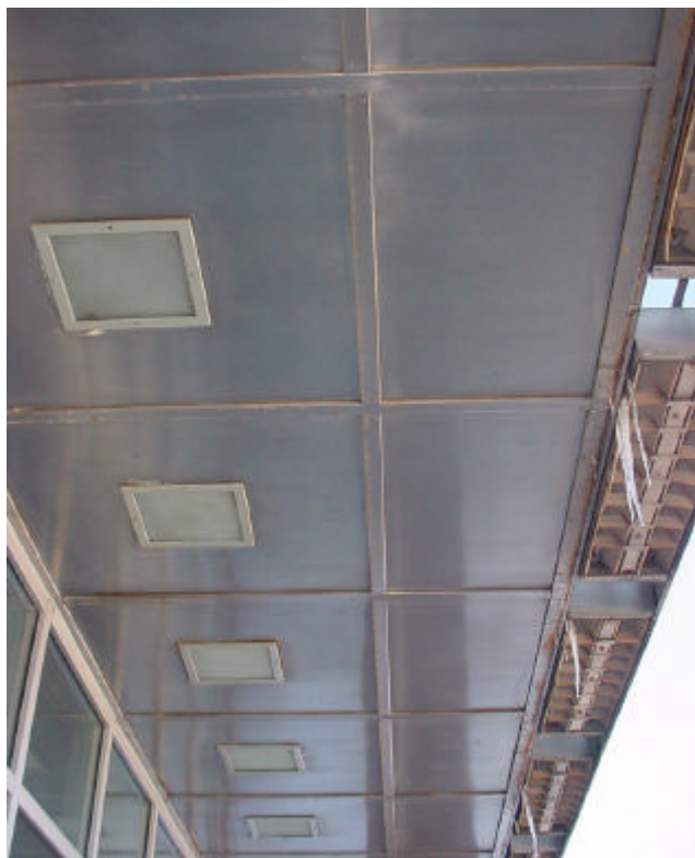
Photo no 23 État actuel de la marquise de l'entrée principale Jarry
