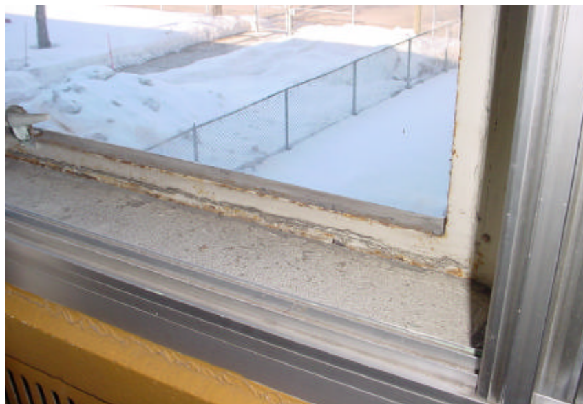
Photo no 14 État actuel de la fenestration aux endroits où les fenêtres sont d'origine (façade l'Esplanade)
