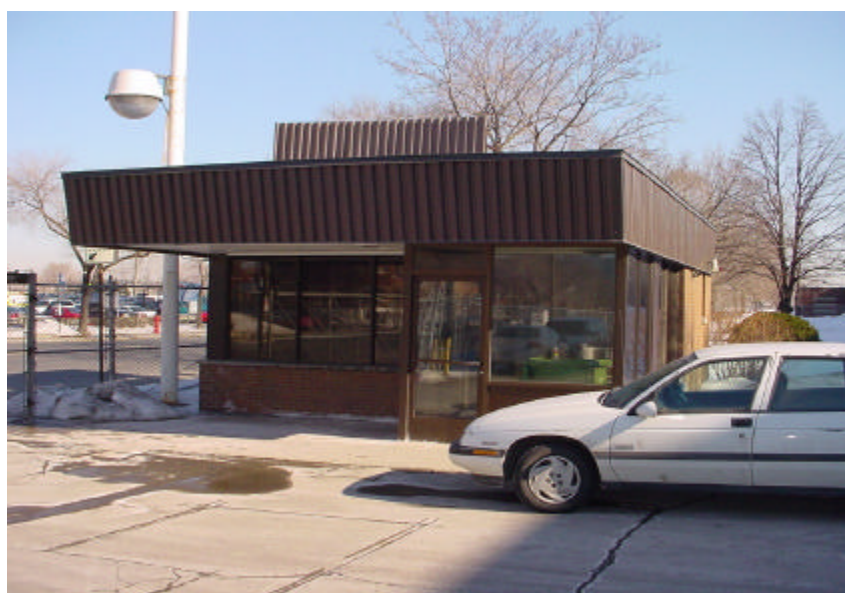
Photo n° 3 Vue d'ensemble du poste guérite existant
