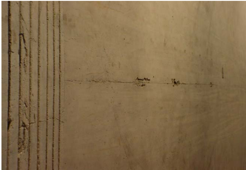
Photo no 6 État général des surfaces de plancher dans les garages
