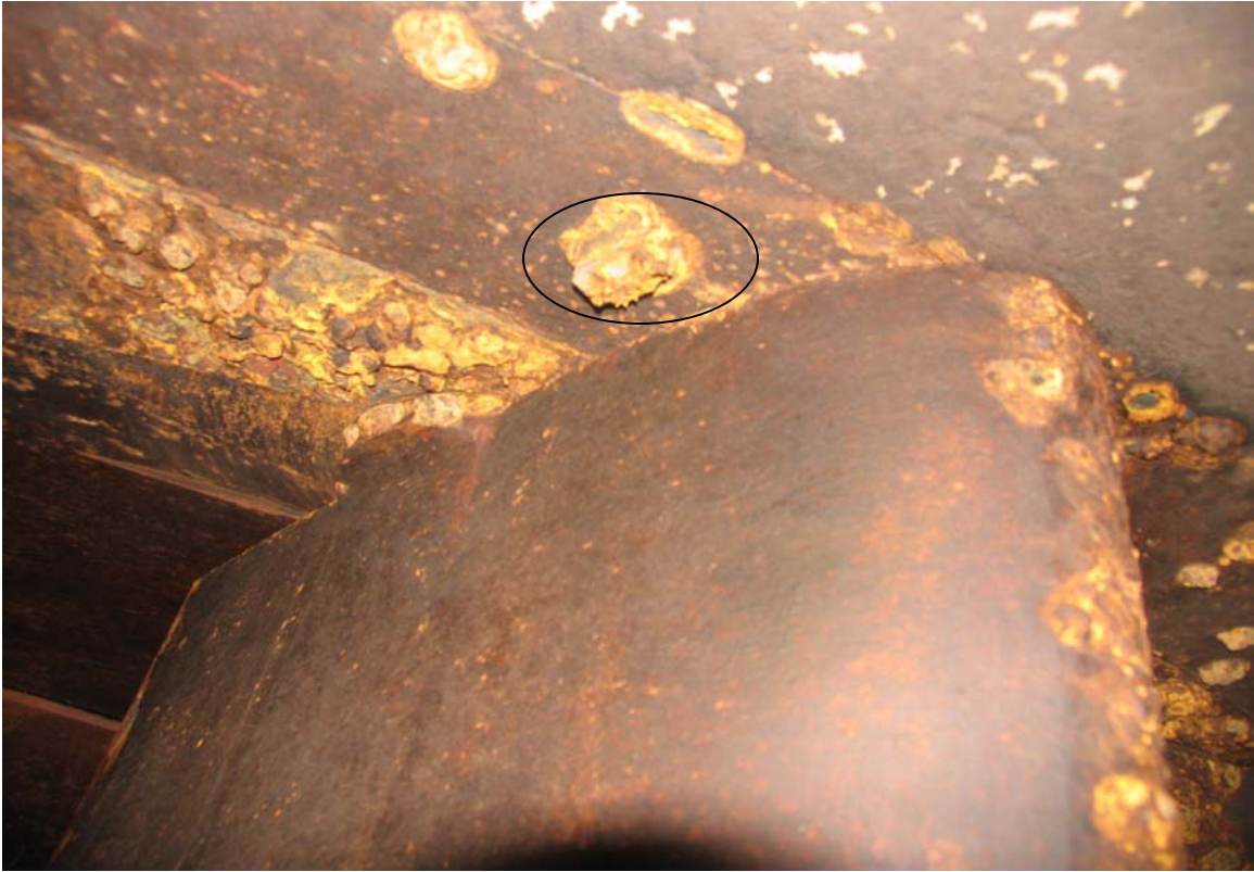
Figure 5: Bloc de butée des directrices
