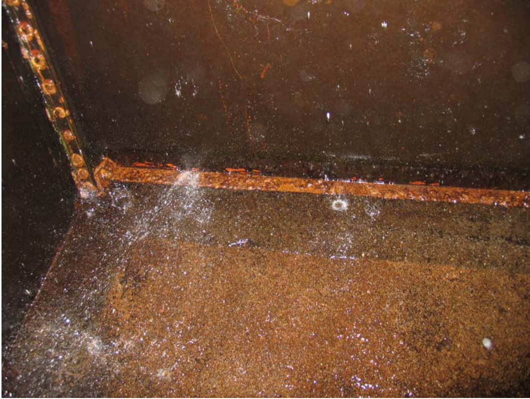
Figure 12: Seuil de la vanne amont 3A
