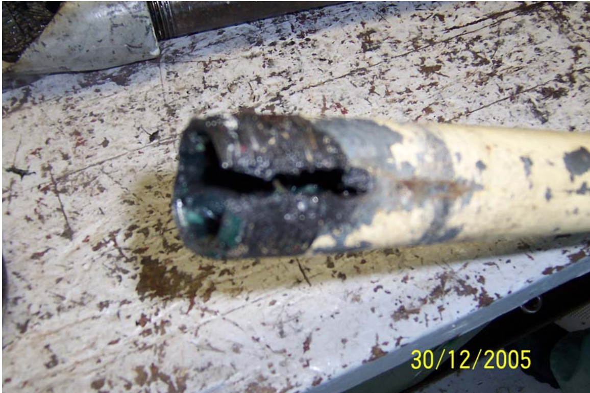
Figure 6: Dommages au tuyau de guidage, bris précédent du câble
