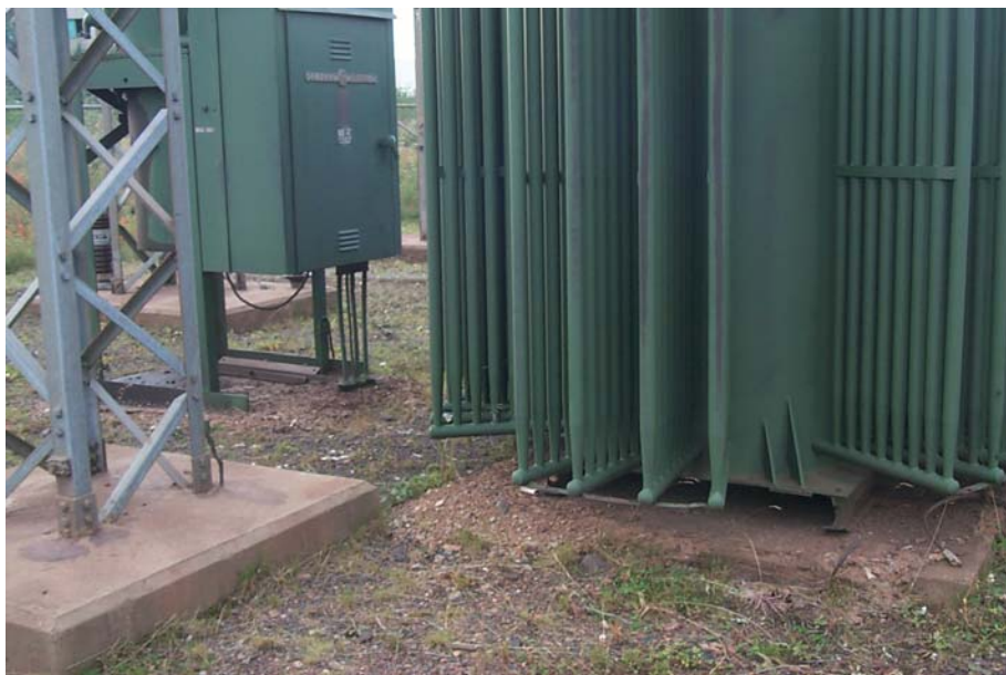
Photo 38: Fondation de béton petit poste Schefferville
