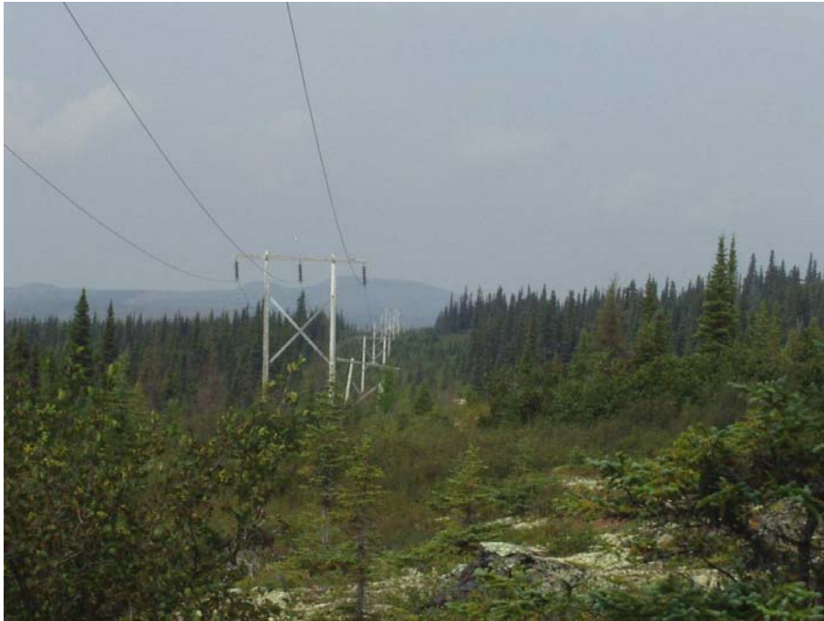
Photo 33: Structures inclinées
