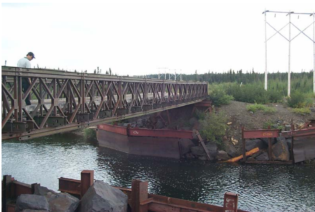
Photo 24: Mur de soutènement du pont Bailey
