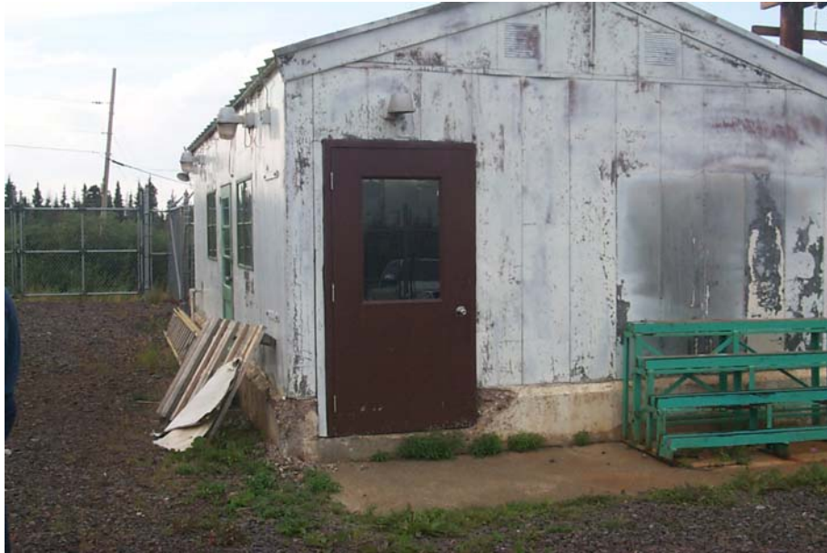
Photo 37: Bâtiment de commande
