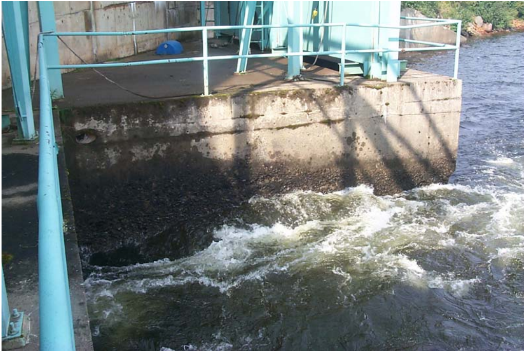
Photo 7: Érosion des piliers
