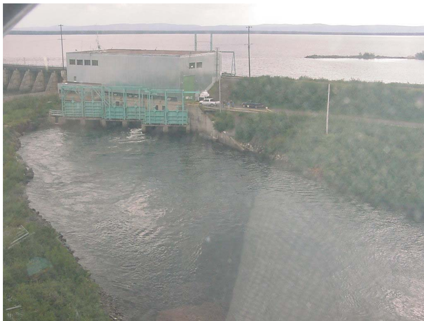
Photo 1: Vue de la centrale
