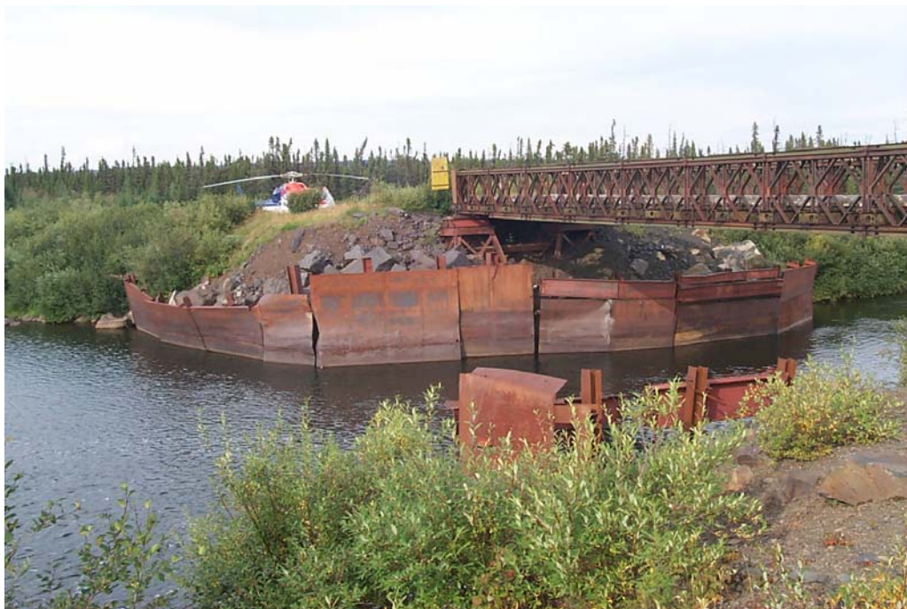
Photo 23: Mur de soutènement du pont Bailey
