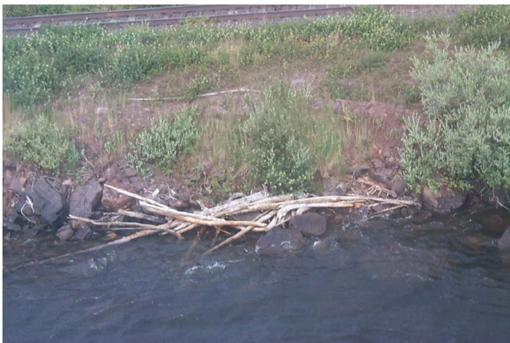
Photo 20: Perré digue rive sud
