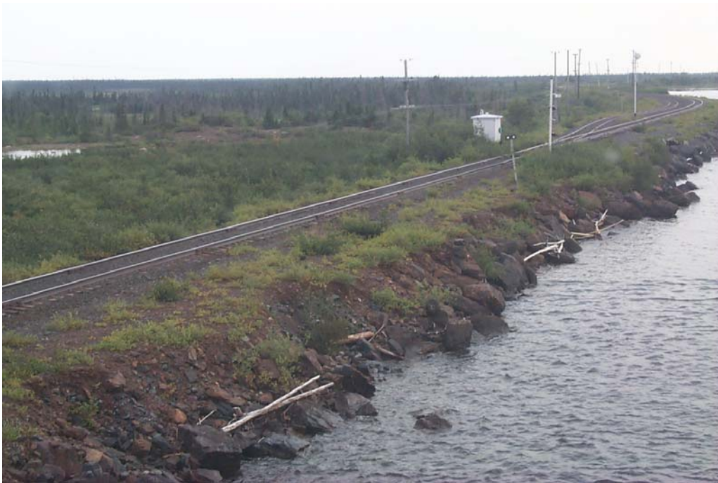
Photo 17: Perré des digues
