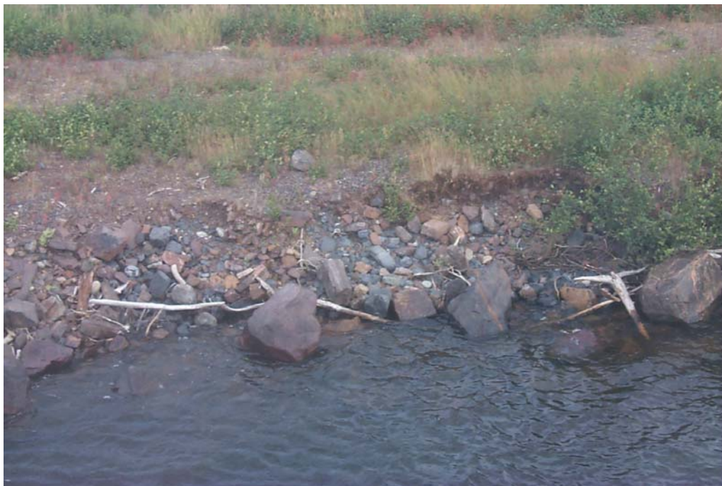
Photo 19: Perré digue rive sud
