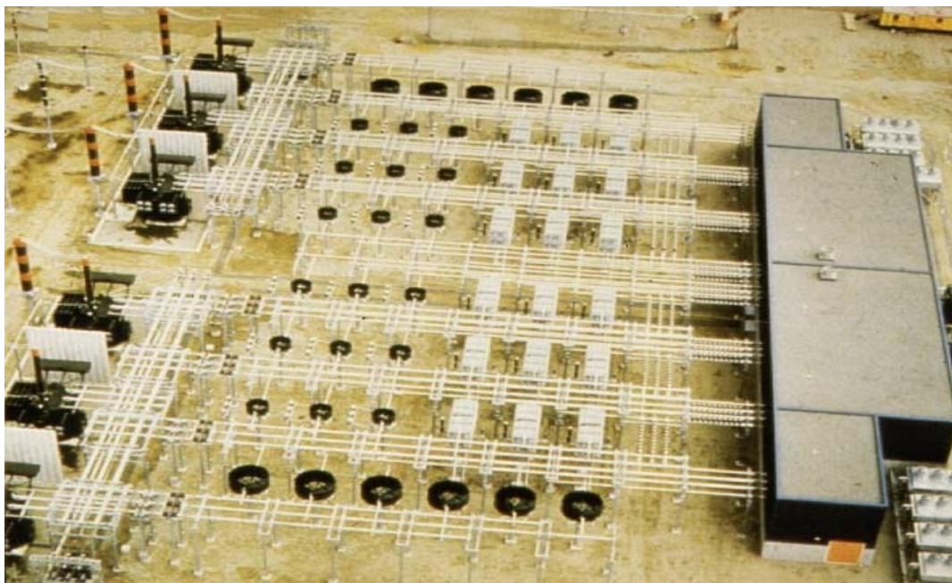
Photo 4 – Compensateur statique (CLC)
