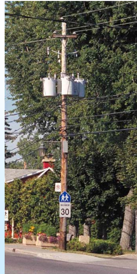
3 transformateurs (à titre comparatif)
