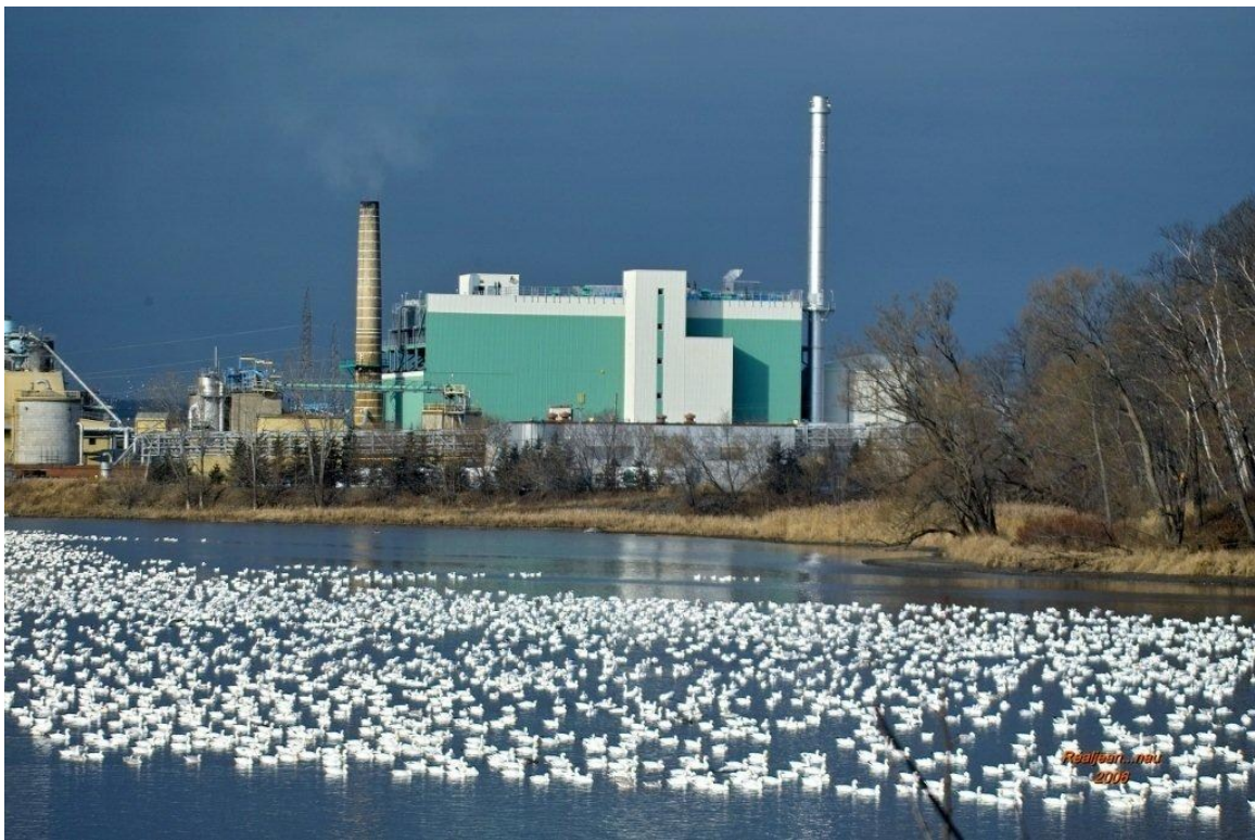
Centrale de cogénération de Brompton. Photo : Kruger Énergie
