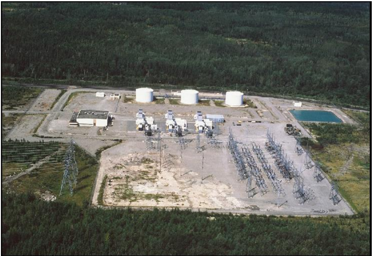
Figure 2 Vue aérienne du poste et de la centrale Cadillac
