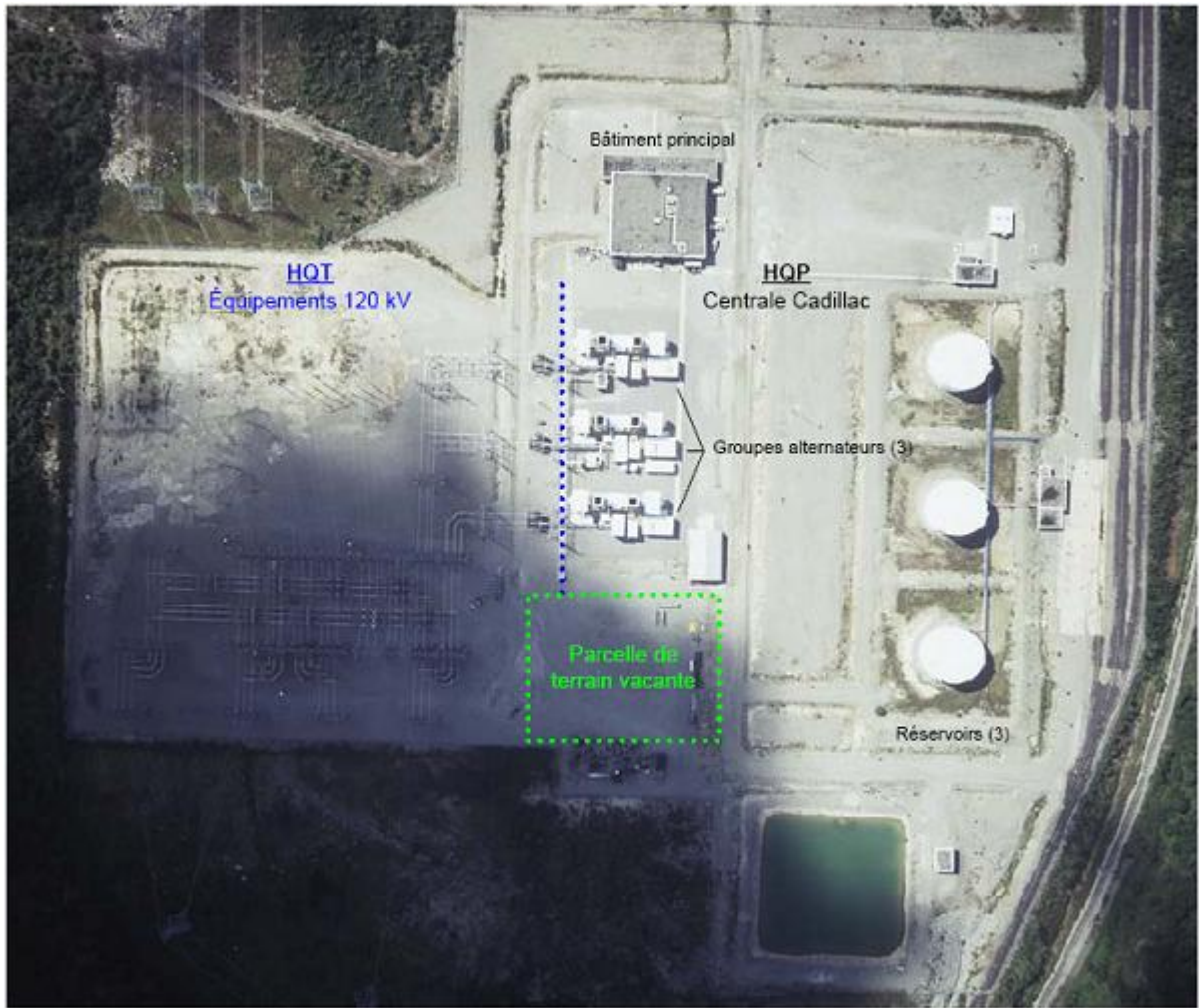
Figure 3 Vue aérienne du poste de la centrale Cadillac et parcelle de terrain vacante
