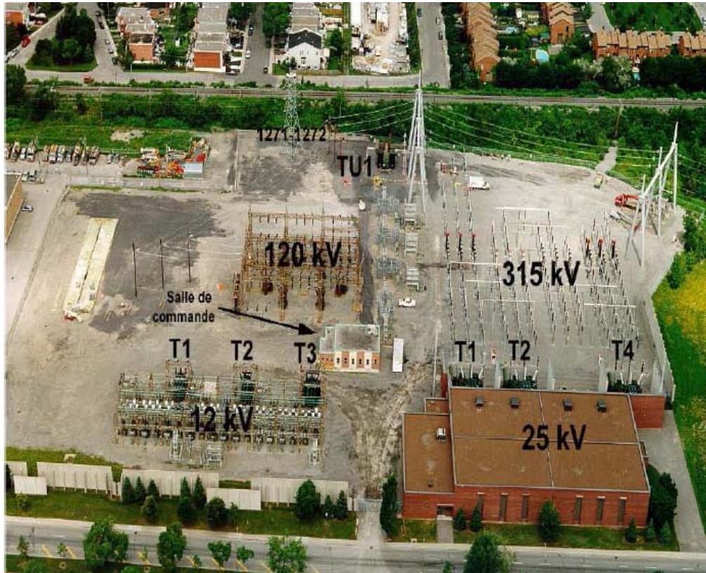
FIGURE 3 POSTES CHARLAND 315-25 kV ET 120-12 kV
