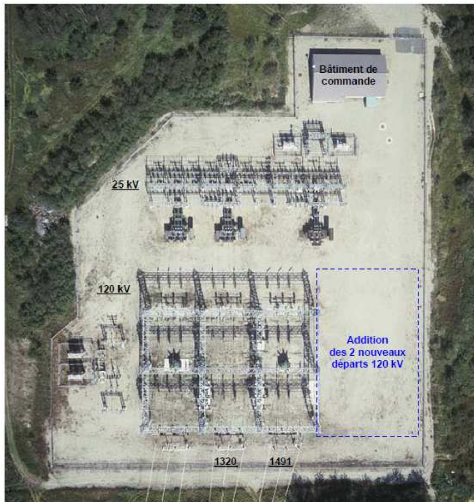
Figure 5 Photo aérienne du poste de Palmarolle
