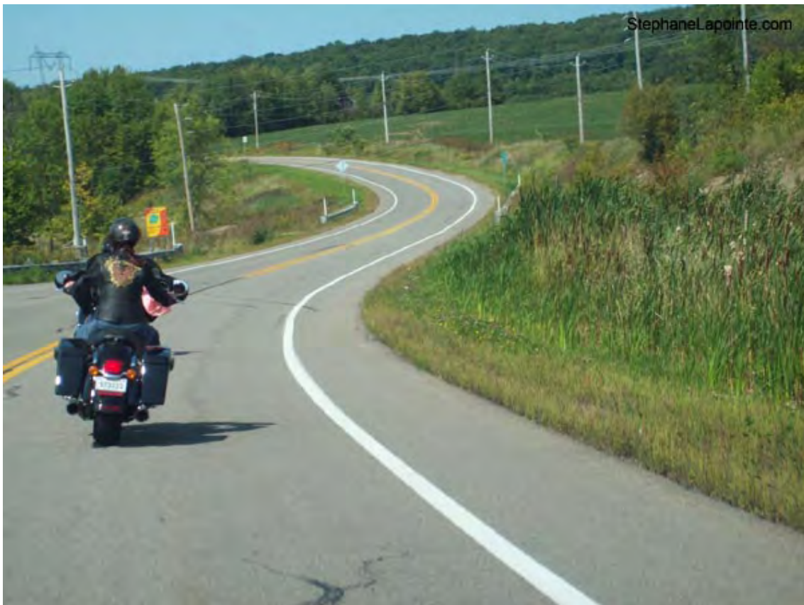
Tronçon de la Route verte sur l'accotement - Route 344 - Région d'Oka, Québec
