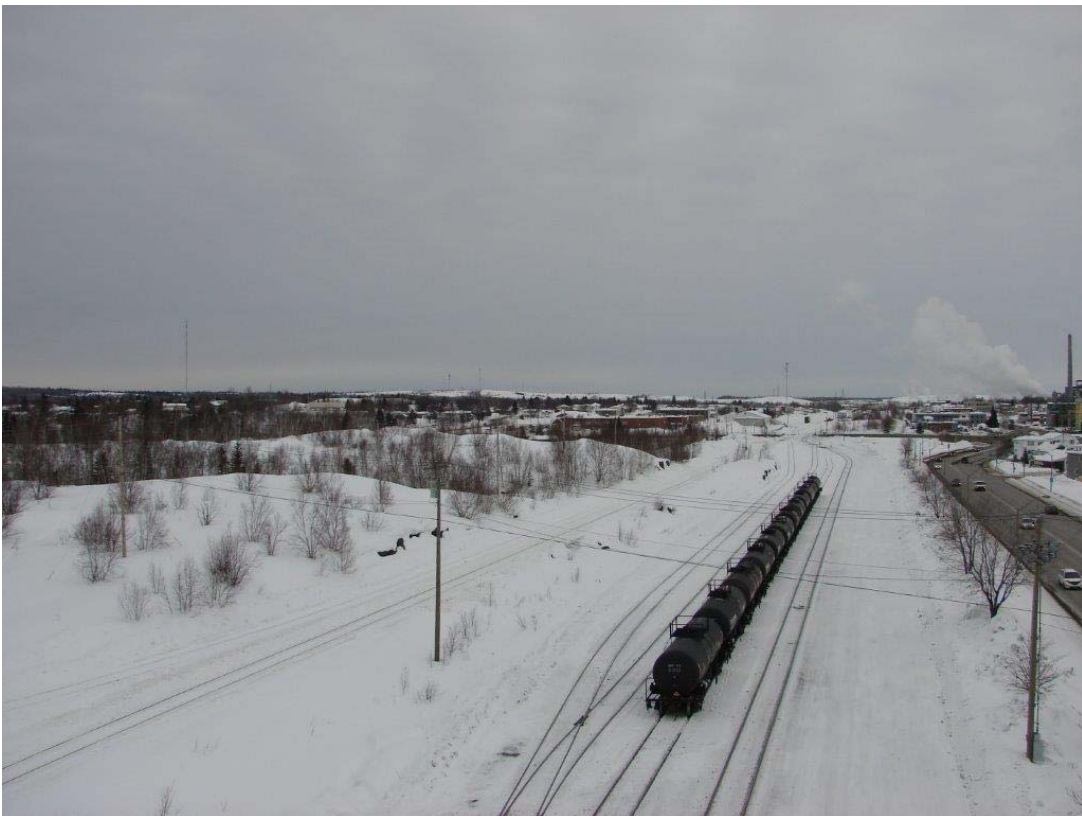
Photos 1 et 2 : Lieux des travaux projetés du Tronçon de ligne, avenue Québec à Rouyn-Noranda.
