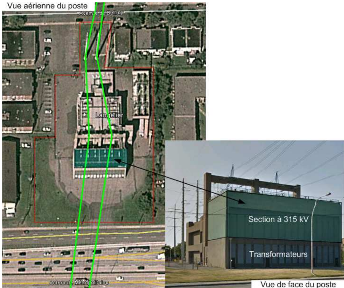
Figure 2 Vue aérienne et de face du poste Langelier
