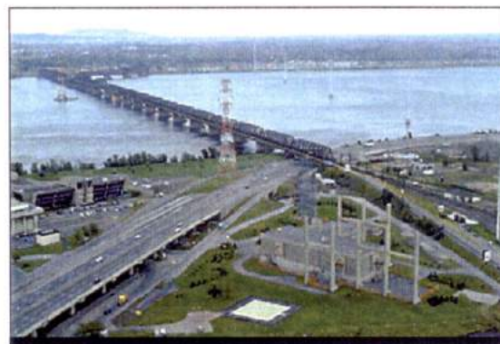
Figure 25 – le poste Viger à 315 kV d'Hydro-Québec, à Montréal, a été localisé à proximité d'une autoroute, de voies de chemin de fer et de secteurs à caractère industriel ;
