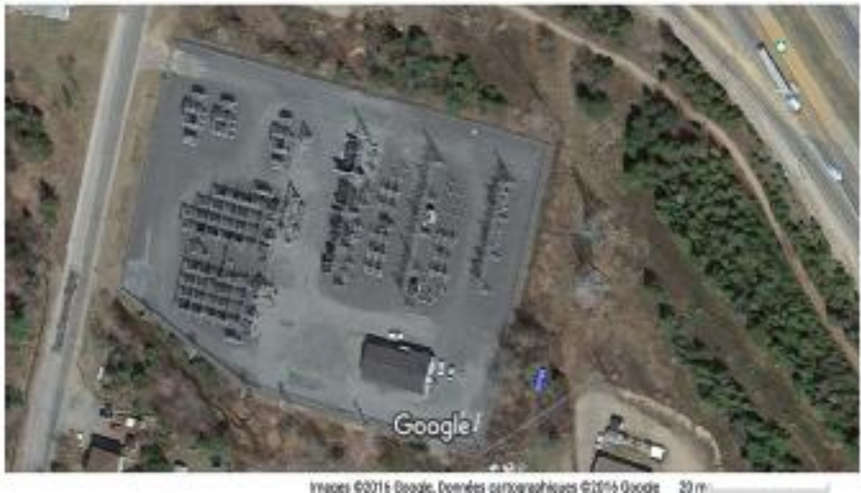
Figure 4.3 - Poste Sainte-Agathe vue détaillée 26
