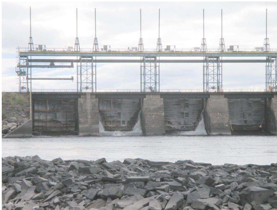
FIGURE 1 : VUE D'ENSEMBLE DE L'ÉVACUATEUR DE CRUES PRINCIPAL
