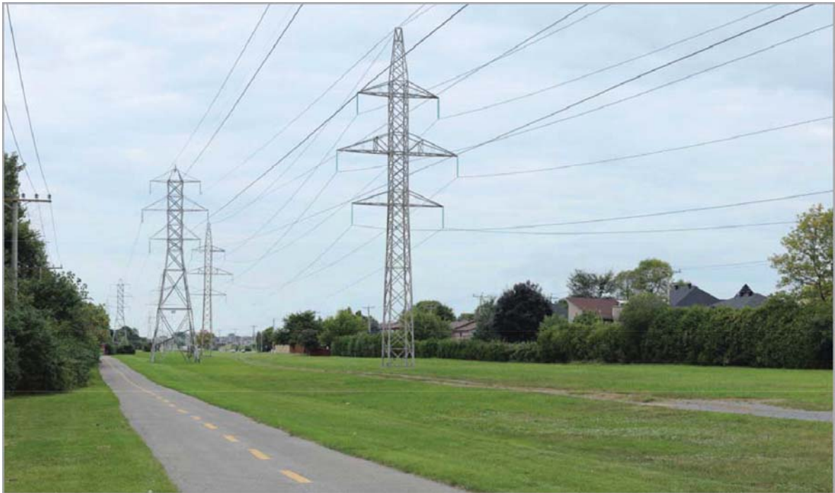
Figure 10 La vue simulée de la ligne à 315 kV sur pylônes en treillis
