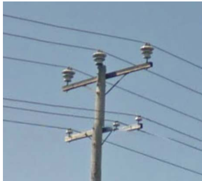
Figure 2 Exemple de poteau, réseau conjoint
