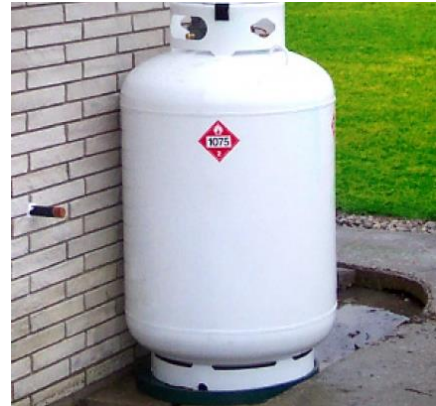
Figure 11 Réservoir de propane, format résidentiel
