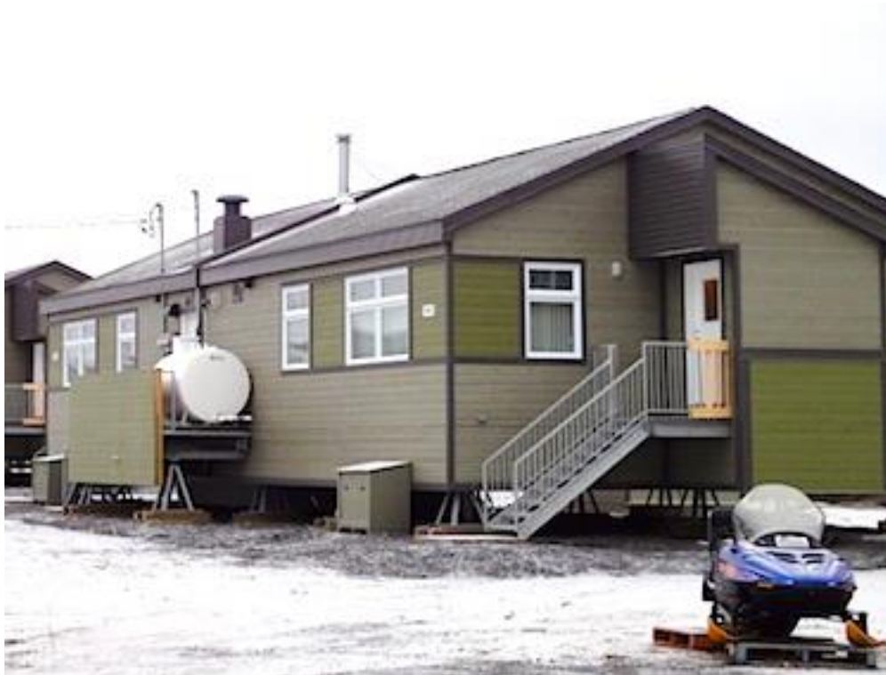
Figure 13 Résidence de Nunatsiaq avec son réservoir à l'huile de chauffage
