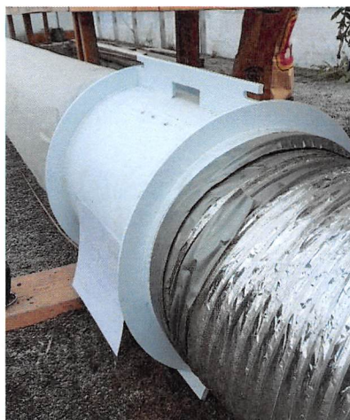
Figure 8 – Conduite de chauffage de la serre (18 octobre 2018)
