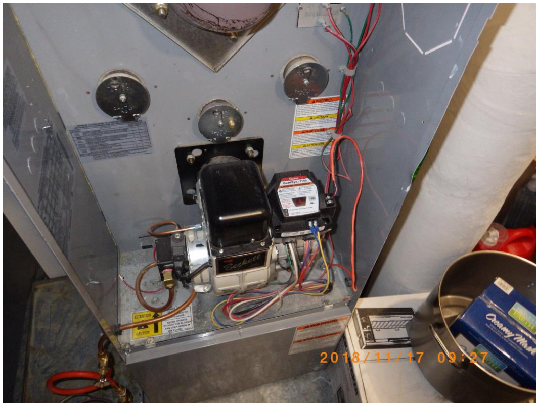
Fournaise au mazout
