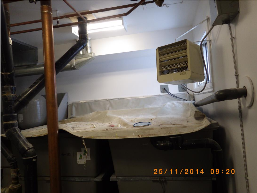
Aérotherme électrique
