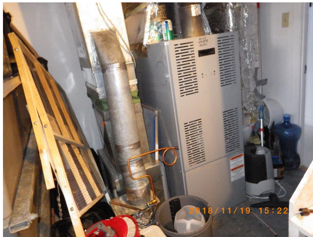
Fournaise au mazout et entrée d'air frais sur la fournaise
