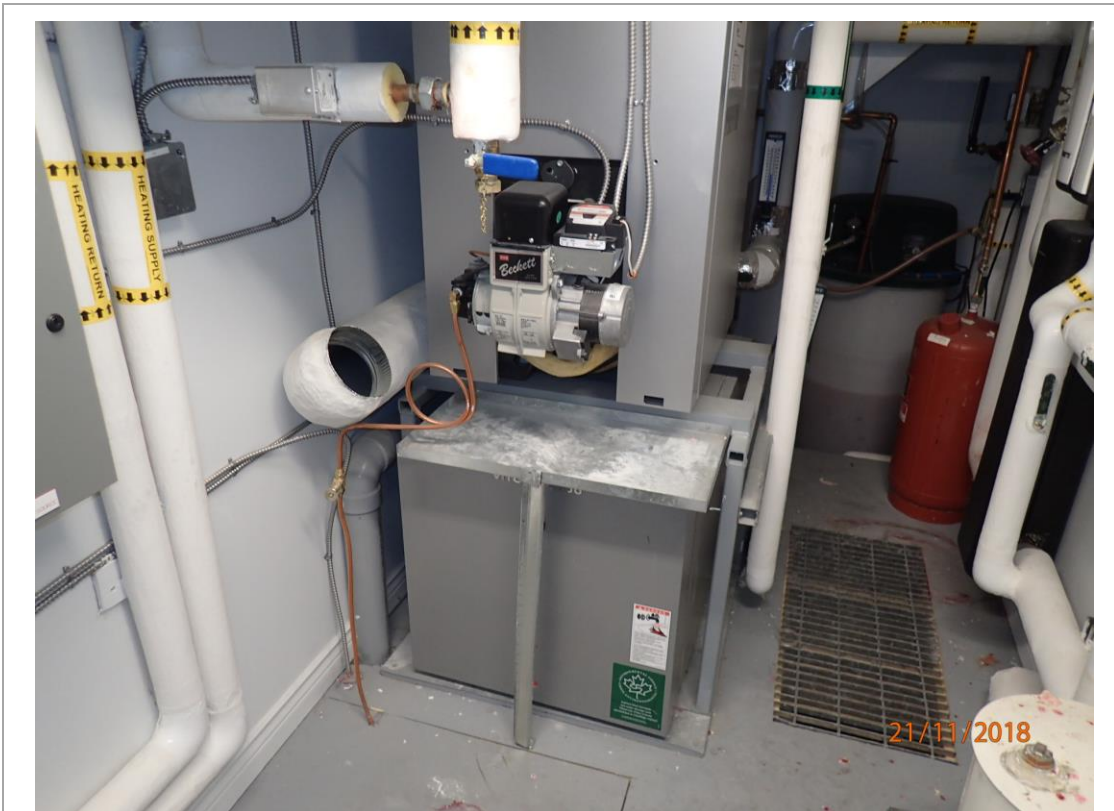
Chaudière au mazout
