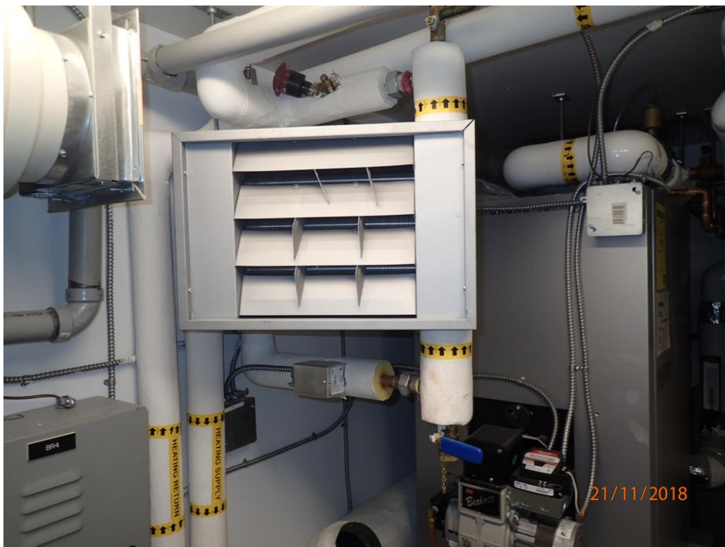
Aérotherme à l'eau chaude alimenté au mazout
