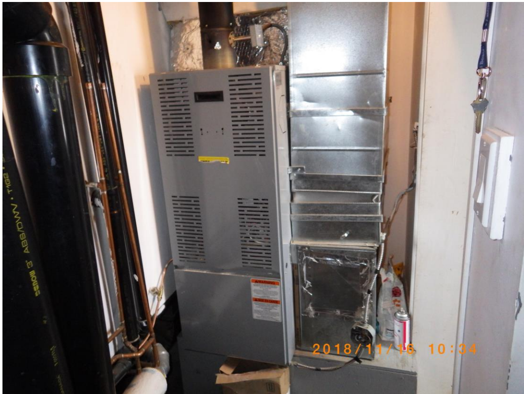
Fournaise au mazout
