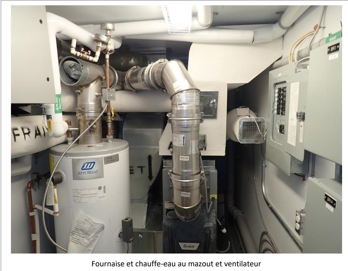
Chaudière au mazout
