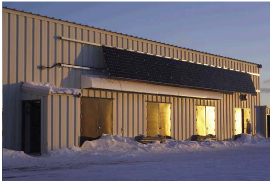
Figure 3 : Champ solaire de 15 panneaux - installation sur le mur de la centrale
