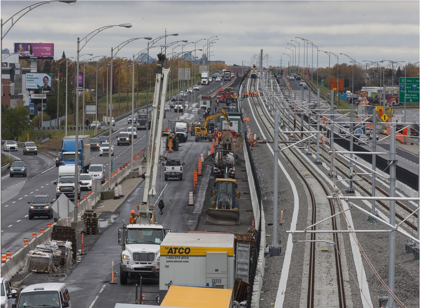
Photo: Jacques Nadeau Le Devoir Un tronçon du Réseau express métropolitain (REM) en construction
