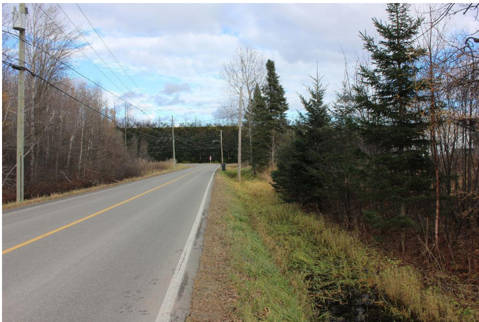
Vue du 18500 rang Sainte-Marguerite après la réalisation du projet
