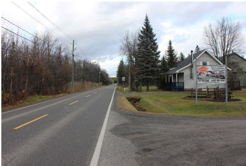
Vue à la hauteur du 17850 rang Sainte-Marguerite après la réalisation du projet
