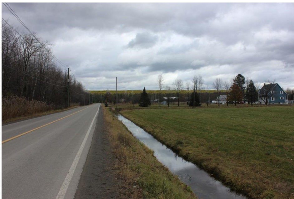
Vue du 18096 rang Sainte-Marguerite après la réalisation du projet
