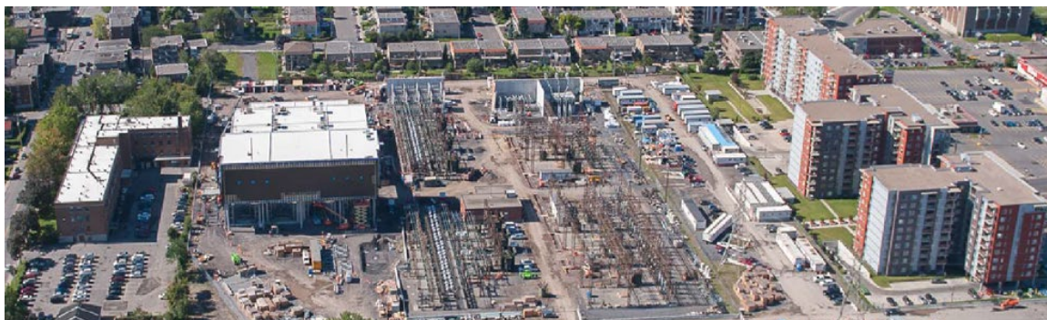
Figure 2 Nouveau poste Bélanger 315-25 kV en construction 2
