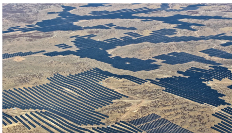
Photo: Agence France-Presse Vue aérienne de panneaux solaires d'une centrale photovoltaïque à Yinchuan, dans le nord de la Chine.
