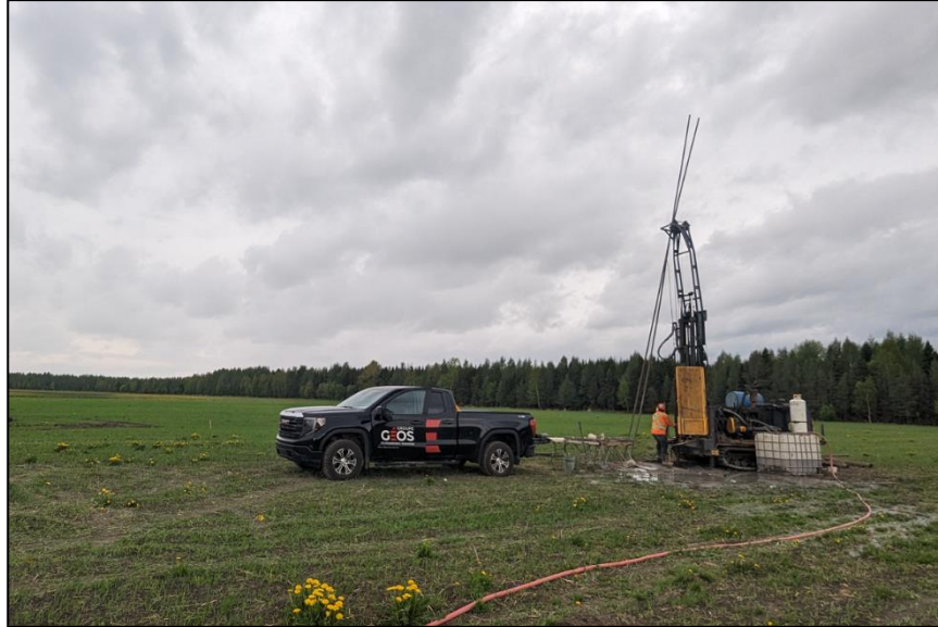
Vue du forage 24F09
