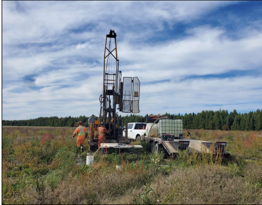
Vue du forage 22F2
