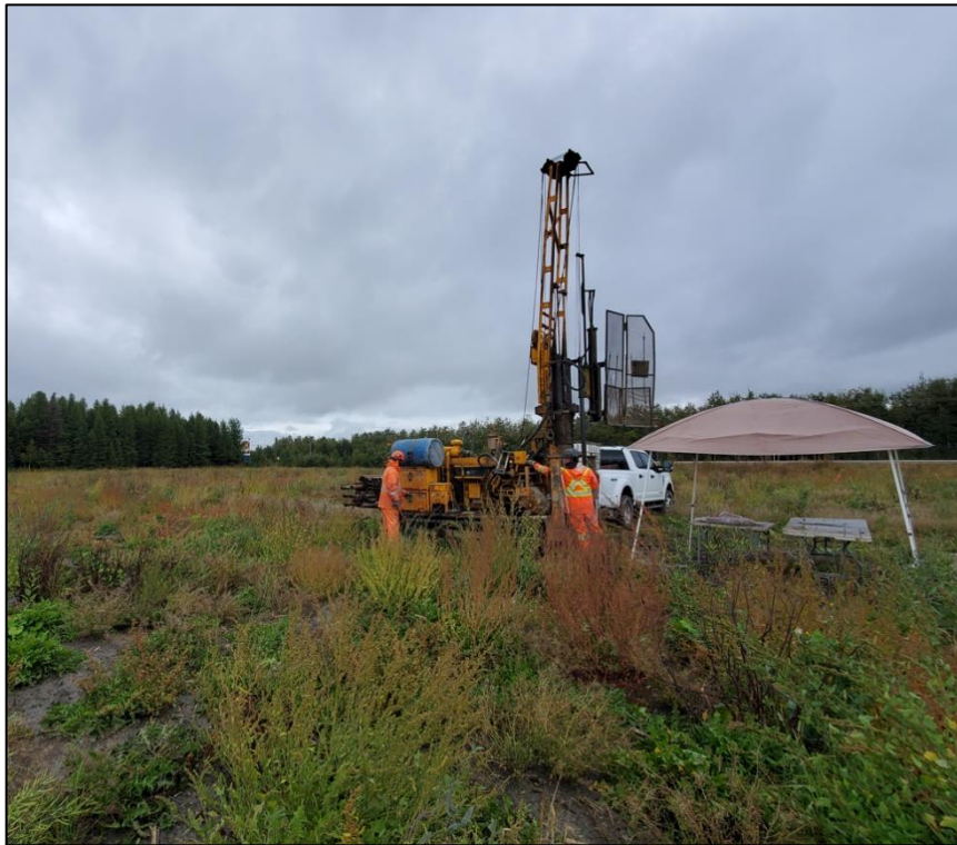
Vue du forage 22F5
