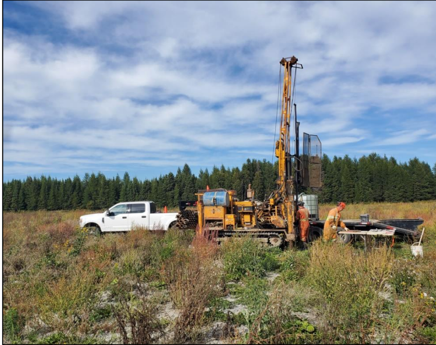
Vue du forage 22F4
