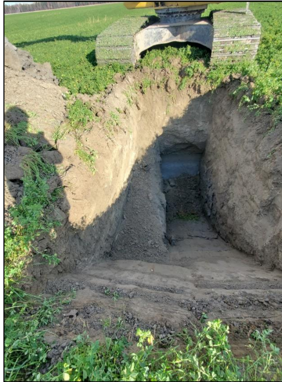
Vue de la tranchée 22TR1
