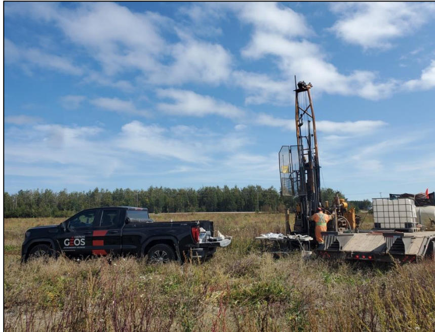
Vue du forage 22F8
