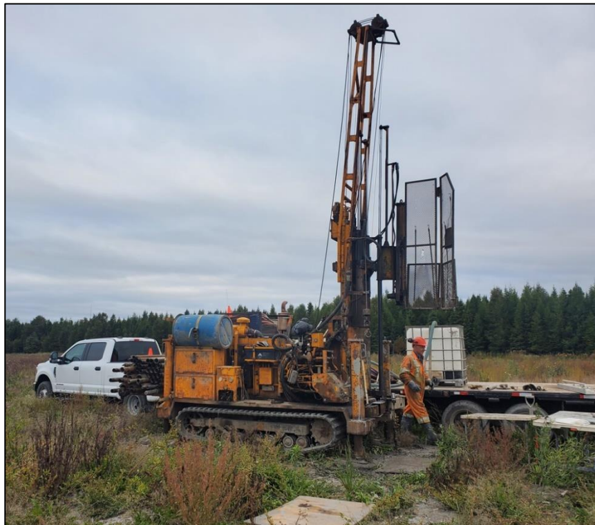
Vue du forage 22F3
