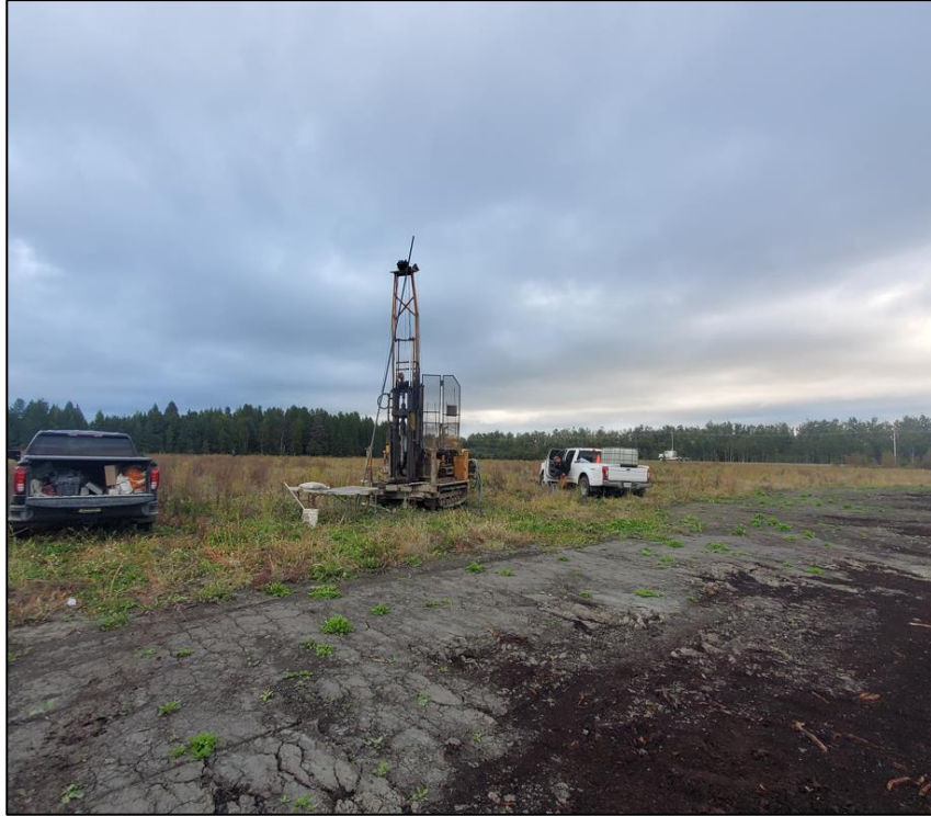
Vue du forage 22F7
