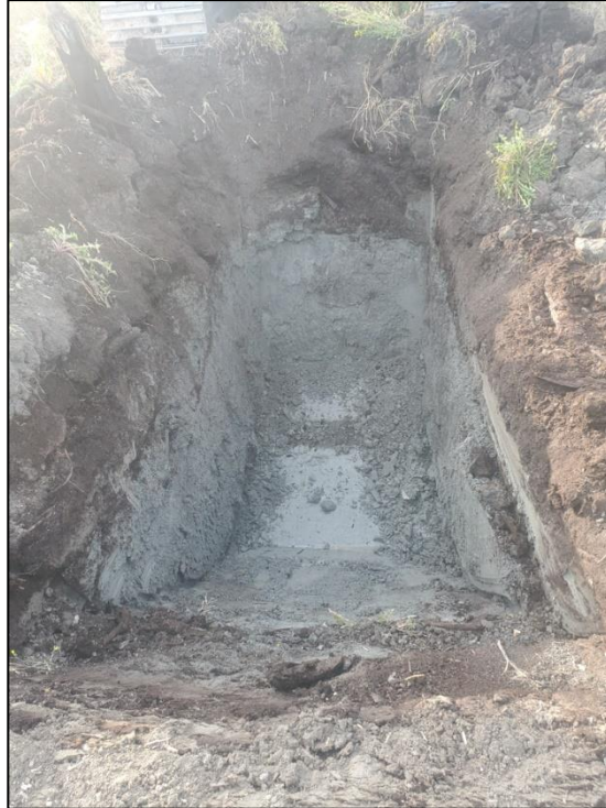
Vue de la tranchée 22TR3
