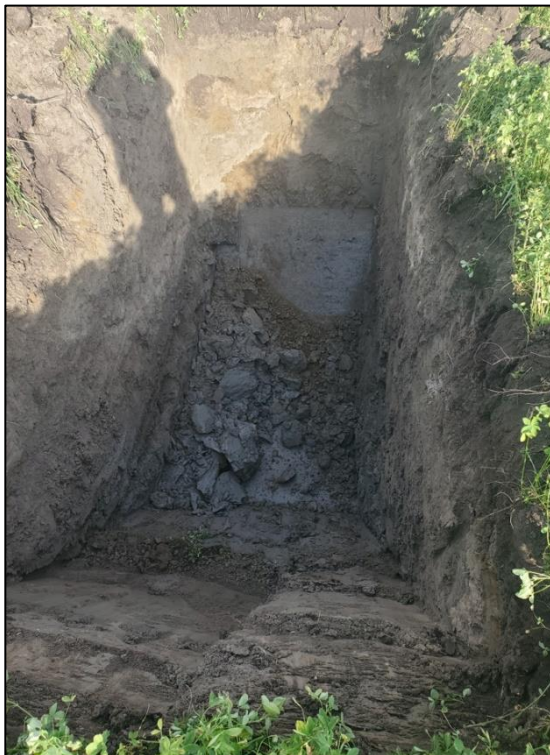
Vue de la tranchée 22TR2
