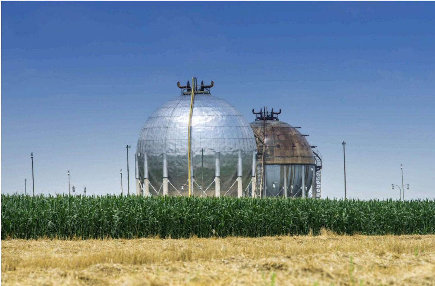
Réservoirs de stockage de gaz naturel dans un champ agricole (Photo: 123RF)
